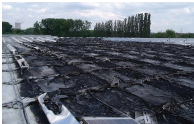
Вид крыши после повреждения
